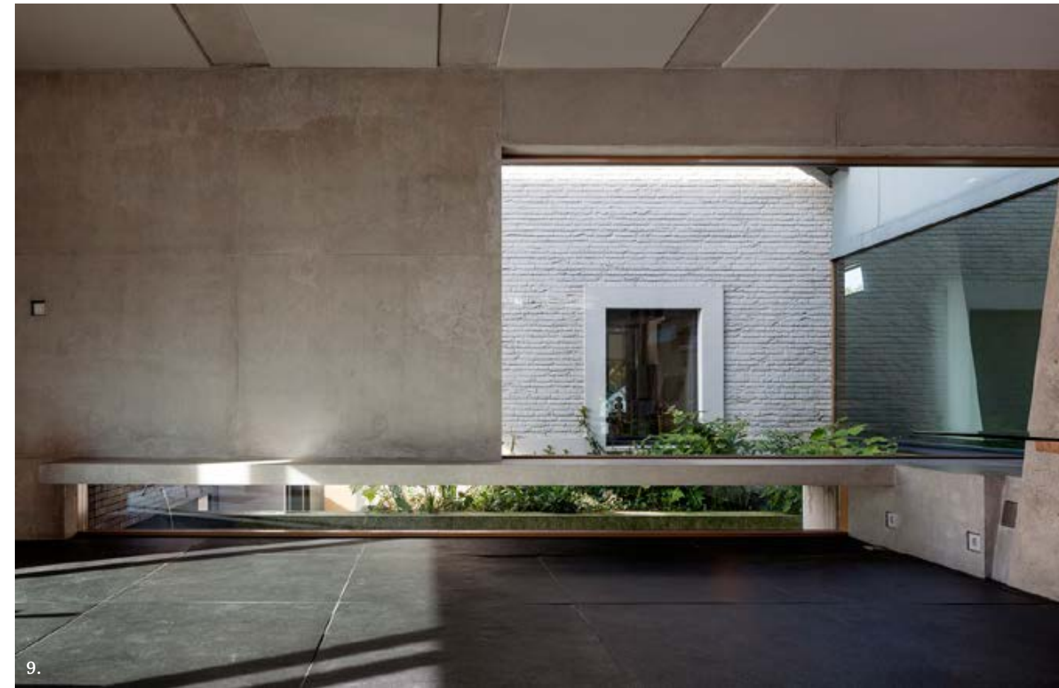
9. De hele betonnen sculptuur werkt constructief samen om de overspanning van het grote raam in de zijmuur, tussen de woonkamer en patio, op te vangen.
